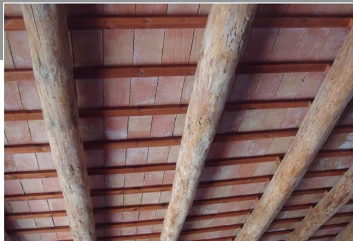
Per fer un sostre o una escala o per cobrir espais entre arcades o parets, etc., es fa un primer full amb rajola o maons fins col·locats amb Ciment Ràpid Marfil Natural de mina. A sobre es disposen un o més fulls de maons i morter de ciment i això fa que sigui molt més lleugera que les voltes construïdes amb altres sistemes.
