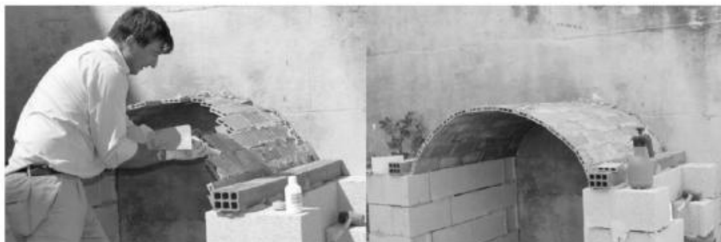
Figura 5. Operario en el proceso de ejecución de la bóveda
