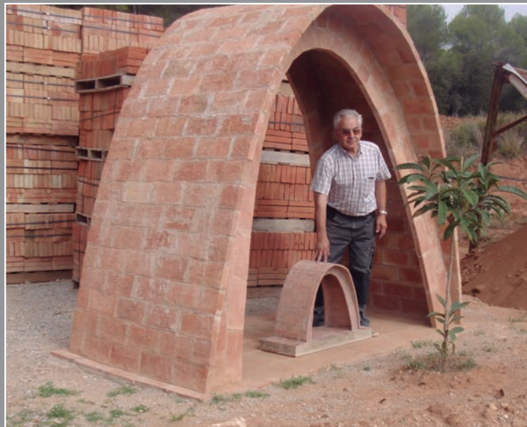
Ramon Guarda ens mostra un exemple de construcció de dos arcs de corbes catenàries i Volta Catalana.
