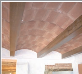
Ramon Guarda ens mostra un exemple de construcció de dos arcs de corbes catenàries i Volta Catalana.
